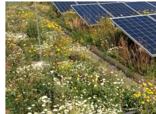
Biodiverse green roof
